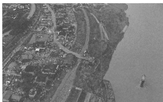
写真4 上空から見た渡地区と相良橋
