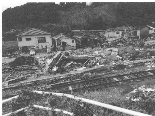
写真3 氾濫流で大破した家屋と線路（渡地区）
