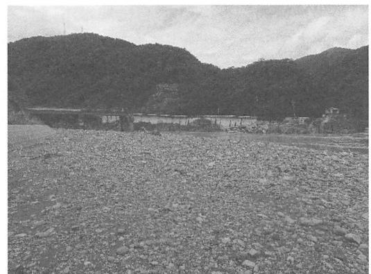
写真1 流失した深水橋(八代市坂本町)
